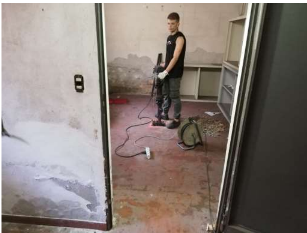
Figura 4.2 – Realizzazione del punto di indagine C1
