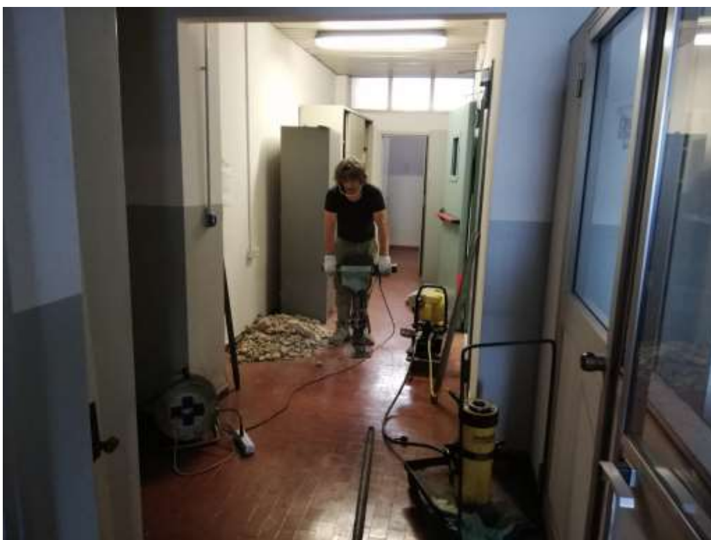
Figura 4.7 – Realizzazione del punto di indagine C6
