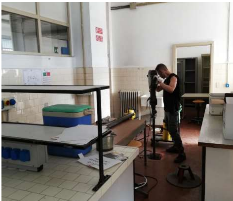
Figura 4.5 – Realizzazione del punto di indagine C4
