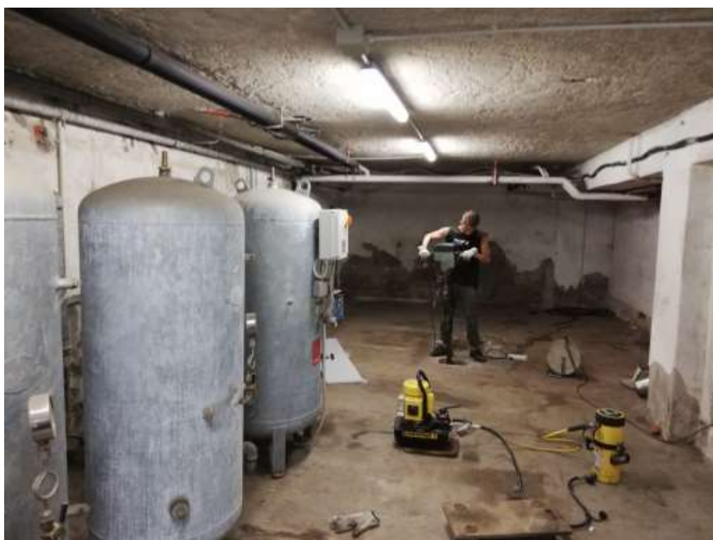
Figura 4.3 – Realizzazione del punto di indagine C2
