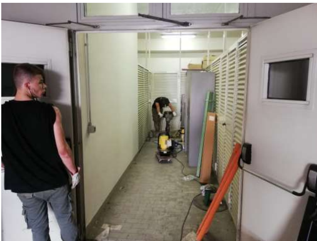
Figura 4.6 – Realizzazione del punto di indagine C5
