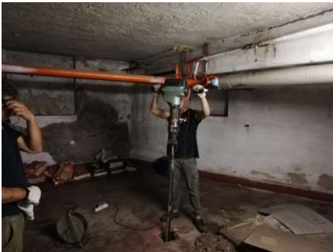
Figura 4.4 – Realizzazione del punto di indagine C3
